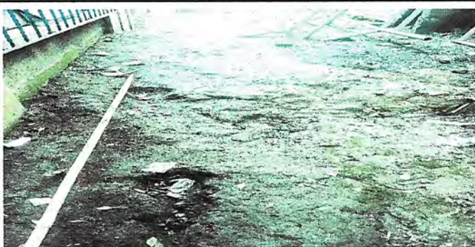
Foto 4: Con fundicion de concreto de 0.075cm de peralte incluye aplanado compactado de suelo y fundición de plancha de 1.50. x 1.50 con total de 104.50m2
