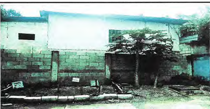
Foto 6: Continuacion cerco de muro Perimetral agregando 1 metro de levantado de Block por 43 mts de largo con block y continuacion de fundicion de columnas existentes + instalacion de Ryzor Rybon Inoxidable
