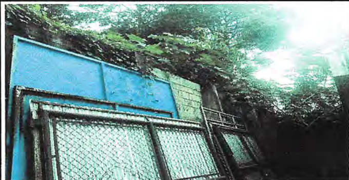
Foto 1: Cerco o Muro Perimetral: Continuación de Cerco o Muro Perimetral Agregando 1 metro de levantado de Block.
