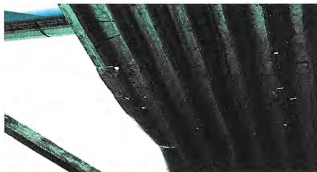
Foto 4: Sustitucion de techo de madera en patio de reuniones con estructura cubriendo una area de 9m por 8m doble altura 72m2 doble altura e instalacion de dos bajadas de 4 pulgadas x 6 metros de largo.
