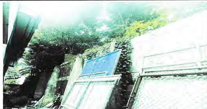
Foto 2: Por 43 Mts de largo con block y continuación de fundion de columnas existentes. + Instalacion de Ryzor Rybon sobre el muro Perimetral con dos hileras con su respectivo soporte de muro
