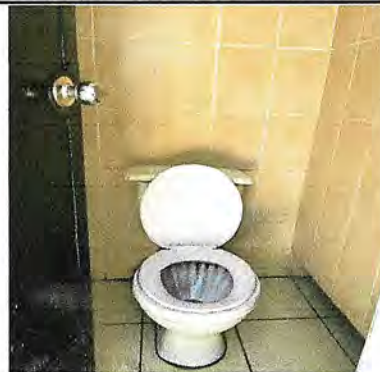
FOTO 2: Servicios Sanitarios y Sus accesorios: Sustitución de inodoros en módulos de baños niños y niñas.
