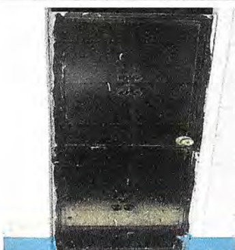
Foto 3: Puertas de metal: Fabricación e instalación de puertas de metal
