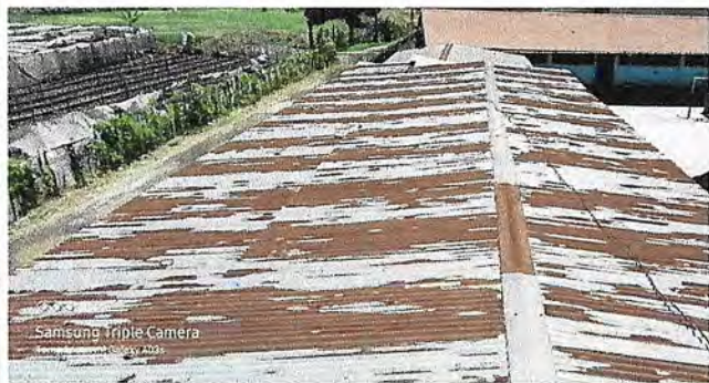
FOTO 1: Cubierta de lámina, sustitución de lámina por lámina troquelada aluzinc calibre 26
