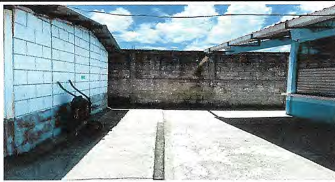
Foto 4: Cubierta de lámina en área de cocina
