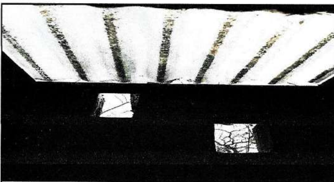
CAMBIO DE LAMINA Y COSTANERA DE MADERA POR GALVANIZADA: EN ÁREA DE COCINA DE LEÑA.
