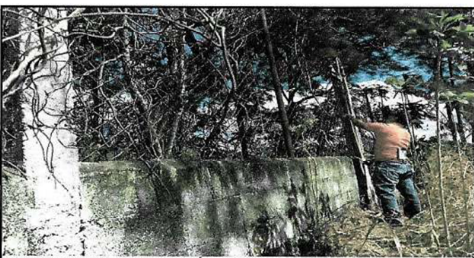
REMOZAMIENTO Y AMPLIACIÓN DE PARED EN AREA NORTE DE LA ESCUELA
