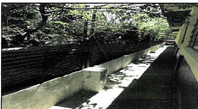
REMOZAMIENTO Y AMPLIACIÓN DE MURO PERIMETRAL EN ÁREA DE ENTRADA, ORIENTE DE LA ESCUELA.
