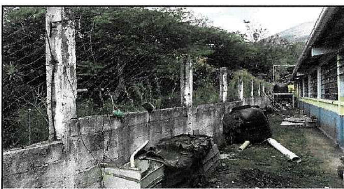
REMOZAMIENTO Y AMPLIACIÓN EN PADRE EN AREA OCCIDENTE DE LA ESCUELA.
