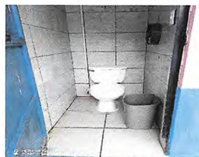
Foto 4: cambio de dos sanitarios area de sanitarios
