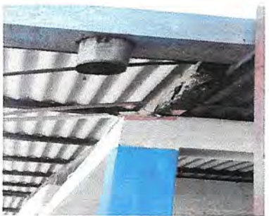
Foto 5: canales y BAJADA DE AGUA PLUVIAL
