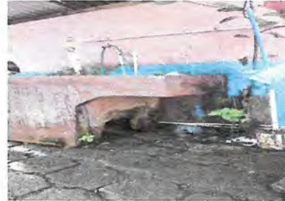
Foto 6: REPARACIÓN DE REPELLO Y CERNIDO en área de pila 7m²
