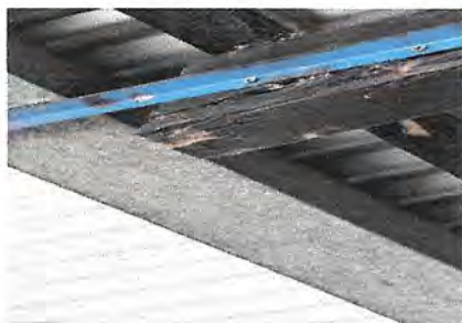
Foto 1: patio 3 sustrucción de estructura de soporte de madera por metal y cubierta de lámina 210 M². en total . sustrucción de 42 metros lineales de canal que se encuentra deteriorado
