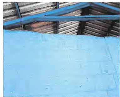
Foto 3: agregado de pared 11m² en area de cocina
