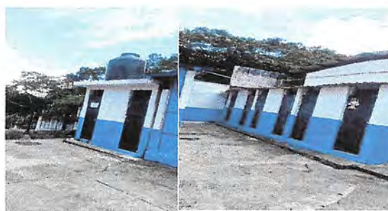
Foto 6: sombra para sanitarios 10 metros lineales
