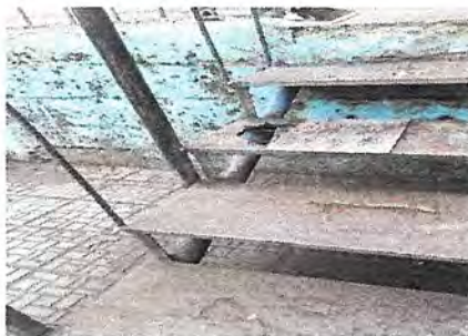
Foto 3: patio 3 gradas sustrucción de gradas
