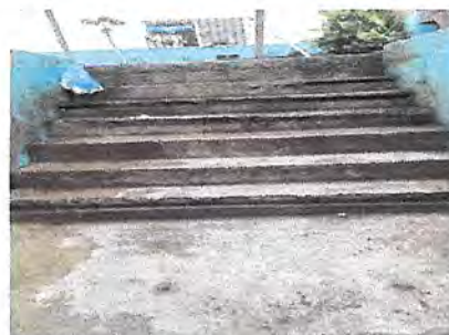
Foto 4: patio No. 2 remozamiento de gradas
