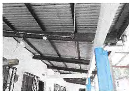
Foto 2: reparación de sistema eléctrico 110 metros lineales
