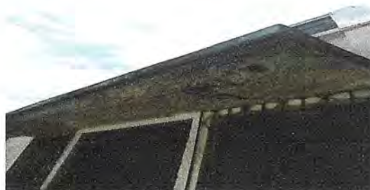
Foto 4: Demolición de losa de techo, por cubierta de lamina ingreso al salon principal
