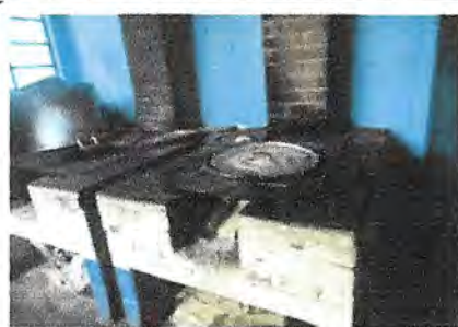
Foto 5: Sustitucion de planchas de cocina a medida
