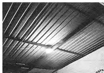
Foto 4: mantenimiento de estructura de techo cocina,corredor y salon principal y aulas de 5to y 6to
