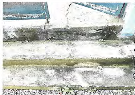
Foto 5: Sustitucion de gradas acceso principal
