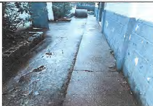
Foto 2: Sustitucion de losa de patio
