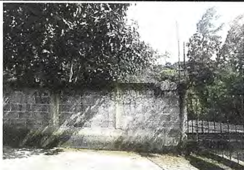
Foto1: circulación de muro perimetral 1 metro de levantado mas malla area de patio
