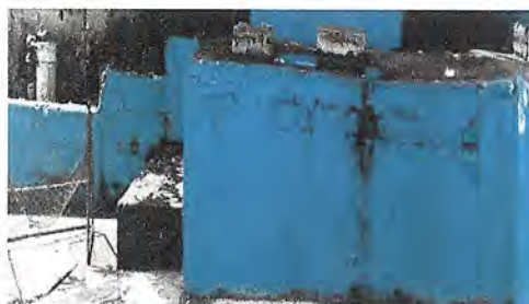
Foto 6: Mantenimiento a fosa septica
