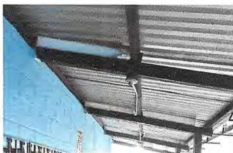
Foto 3: mantenimiento de estructura de techo aulas 2do y 4to
