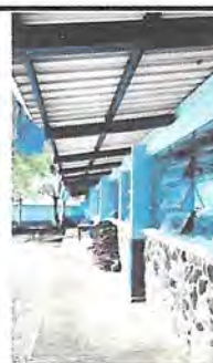
Foto 6: INSTALACION DE CANALES PLUVIALES EN MODULO DE SALONES, 5 BAJANTES PLUVIALES EXPUESTOS EN PARED, FUNDIDOS EN CAMINAMIENTO.
