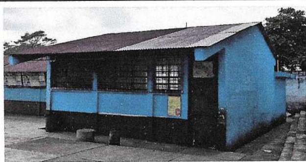
Foto 3: Cubierta de lámina y mantenimiento estructura de techo
