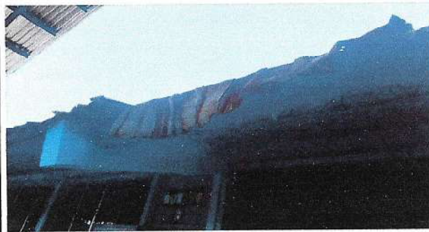
Foto 2: Cubierta de lámina y mantenimiento estructura de techo
