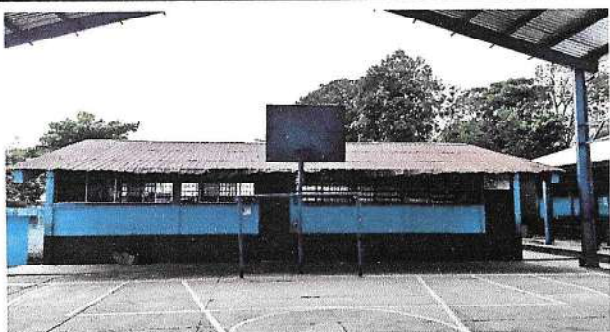
Foto 1: Cubierta de lámina y mantenimiento estructura de techo
