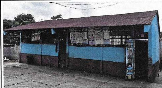
Foto 4: Cubierta de lámina y mantenimiento estructura de techo
