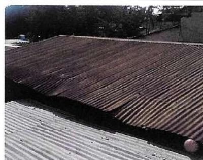
Foto 6: es necesario realizar el cambio de la lámina ya que se encuentra en mal estado tomando en cuenta que la estructura se ve en buenas condiciones.
