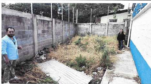
Foto 1: Visita del supervisor educativo para verificar las necesidades de la Escuela para poder tomar los renglones a trabajar con el programa de Mantenimiento de Edificios Escolares
