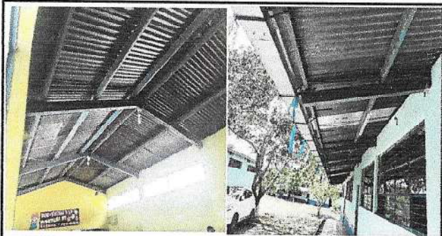
Foto1 y 2: ESTRUCTURA DE TECHO
