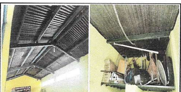
Foto 10 y 11: SISTEMA ELECTRICO
