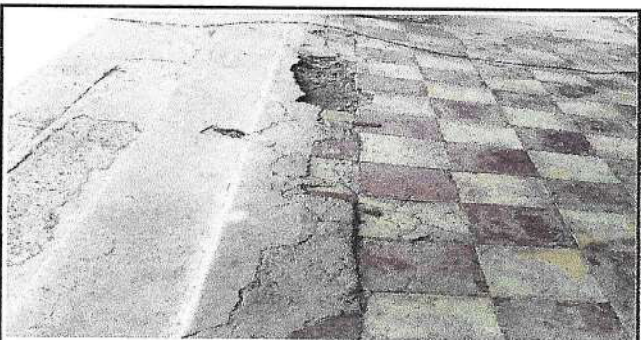
Foto 5: Sustitución de Piso de granito por azulejo
