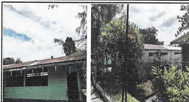
Foto 3 y 4: CUBIERTA DE LAMINA
