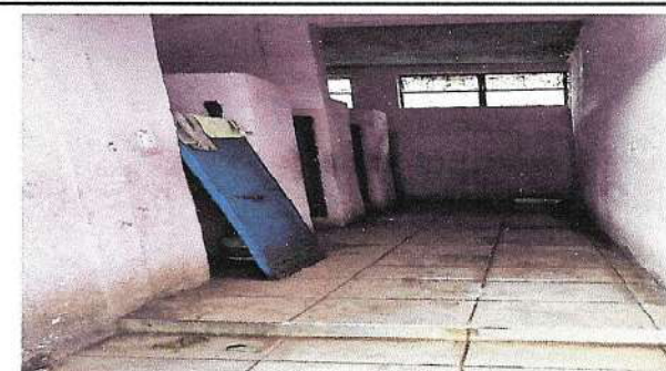
Foto 4: Reparación y pintura de puerta de baños, sustitución de piso y colocación de azulejo
