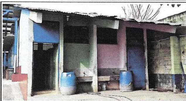
Foto1: Reparación de puerta principal y de puertas de baños
