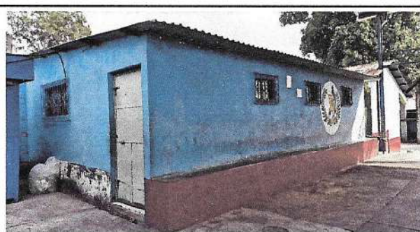
Foto 6: Reparación y ampliación de ventanas
