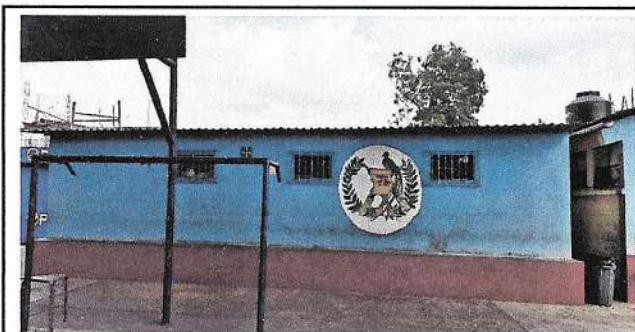
Foto 5: Cubierta de lámina y estructura de techo
