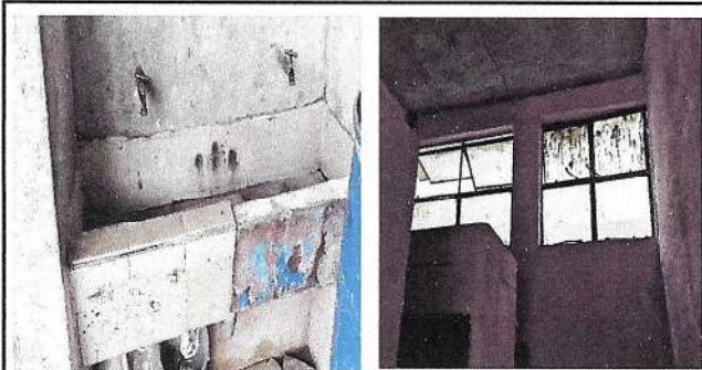
Foto 3: Sustitución de azulejo en lavamanos y reparación de ventanas
