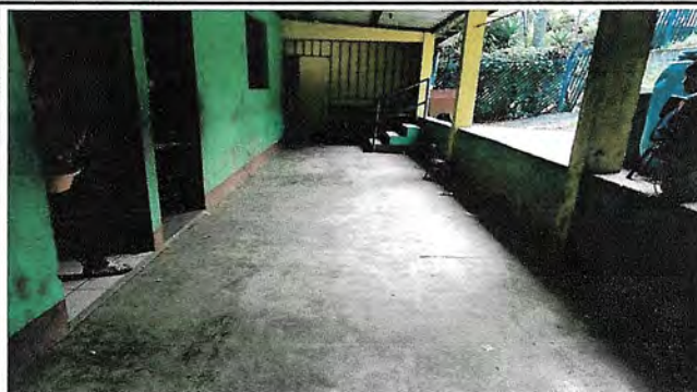
Foto 2: instalacion de piso ceramico corredor
