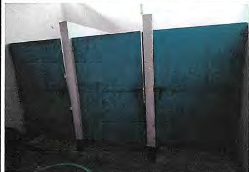
Foto1: Reparacion de puerta de baño para niñas
