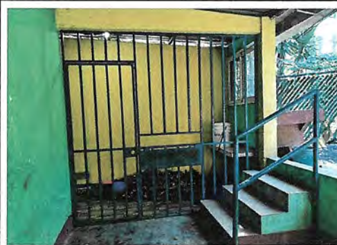
Foto 2: mantenimiento de baranda de entrada de cocina.
