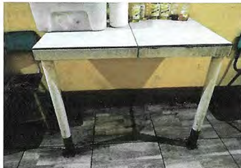
Foto 1: Reparación de mesa de concreto con block tabique
