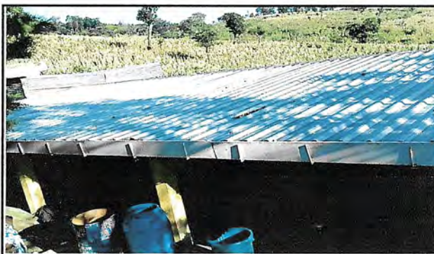
Foto 6: sustitución de cubierta de lamina
