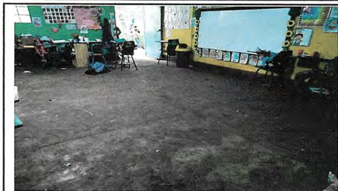
Foto1: colocacion de piso ceramico en el aula 2
