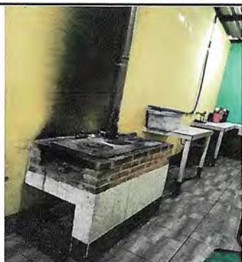
Foto 3: Reparación de plancha artesanal
