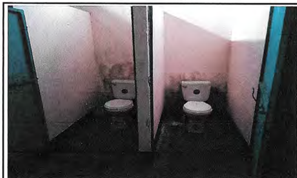
Foto 3: colocacion de azulejos en la pared interior de los baños
