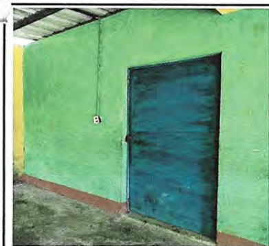
Foto 5: Reparacion de puerta principal de los banos
