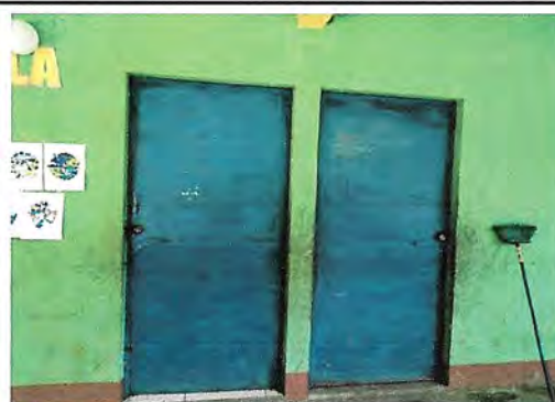
Foto 4: reparacion de puertas de las dos aulas.
