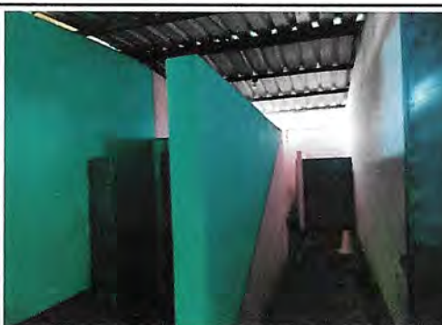
Foto 6: Pintado de baños interiores
