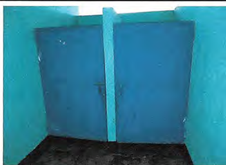
Foto 6: Reparacion de puertas de baño de varones
