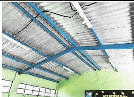
Foto 3: Reparación del sistema eléctrico
