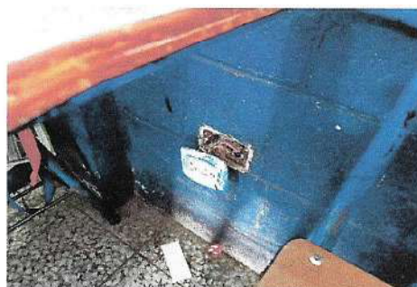
Foto 4: Reparación del sistema eléctrico
