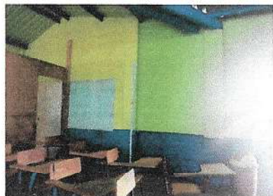
Foto1: Mantenimiento de pintura
