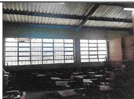
Foto 2: Mantenimiento de pintura
