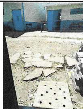
Foto 2: Fundición de losa ingreso posterior de la escuela
