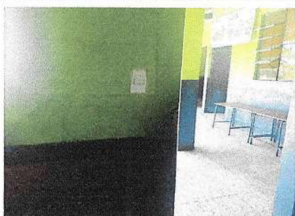
Foto 3: Mantenimiento de pintura
