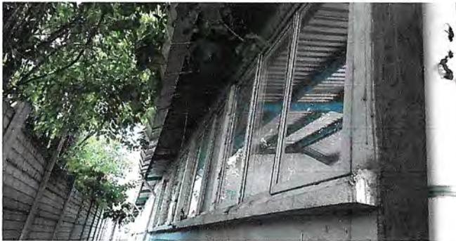
Foto1: colocación de balcones en las aulas parte trasera
