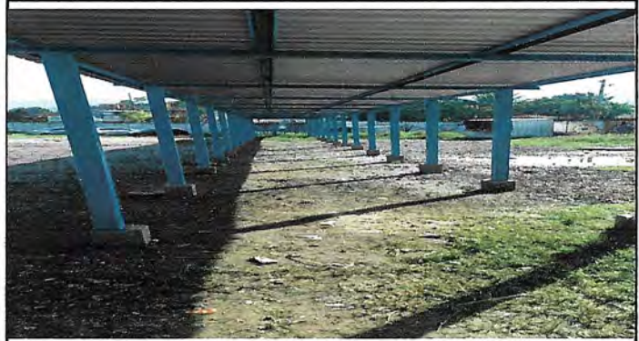
Foto 2: LOSA DE PATIO
