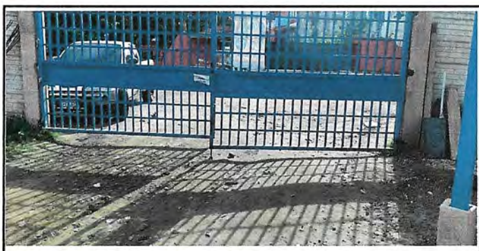
Foto 6: INGRESO AL PORTON
