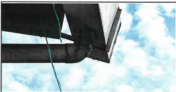
Foto 5: CANALES Y BAJADAS DE AGUA PLUVIAL
