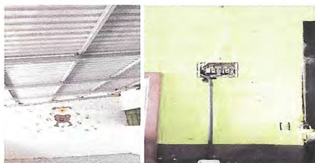
Foto 9: REPARACIÓN DE SISTEMA ELÉCTRICO (Reparación de sistema eléctrico en en aulas, cocina, dirección, que consiste en sustitución 8 unidades de iluminación, 6 tomacorrientes, 6 interruptores simples, caja de circuitos y flipones.)
