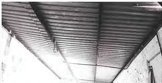
Foto 1: Estructura y cubierta de Lamina (Sustitución de 285m2 de lamina en mal estado en aulas, cocina por lamina troquelada aluzinc (calibre 26) 12 pies. Instalación de lamina tipo flashing en sanitarios en union de muro y lamina con lamina de 4X8 (calibre 26) con dimensiones de 0.50mX2.43m en toda la union, sellar imperfecciones con masilla acrilica tapagoteras.)
