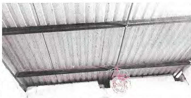
Foto 2: ESTRUCTURA DE TECHO (Mantenimiento a estructura existente que consiste en lijado y aplicación de pintura anticorrosiva en costaneras.)
