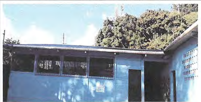
Foto 3: CANALES Y BAJADAS DE AGUA PLUVIAL (Instalación de 37 metros lineales de canal americano c26 0.54mX3.00m con 4 bajadas de agua pluvial de 3 metros lineales, en area de aulas sanitarios. Instalación de 2 bajadas de agua pluvial en area de losa de concreto con 6 metros lineales de tubo pvc 3". Mantenimiento de bajada de agua pluvial en losa de concreto que consiste
