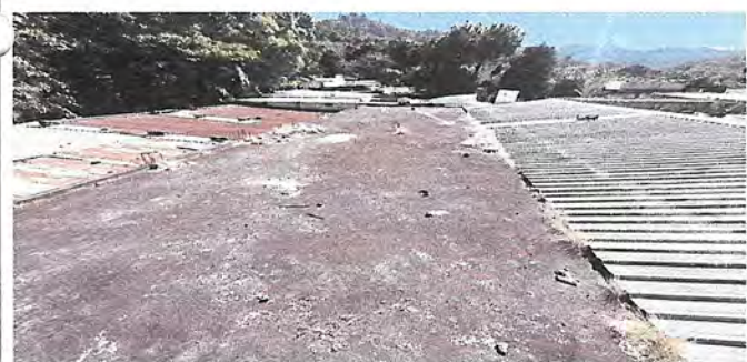
Foto 5: IMPERMEABILIZACIÓN DE LOSA (Corrección de pendientes de pañuelos en losa y dirigir hacia salidas de agua pluvial con un espesor de 2cm con mezcilon premezclado, impermeabilización de 71m2 de losa que consiste en mantenimiento extracción de hongos de humedad y aplicación de impermeabilizante a dos manos de Aqualock impermeabilizante y temorefectante 8000.)
