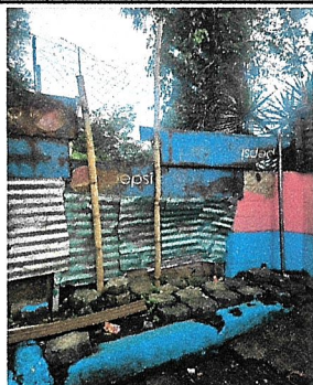
Foto 1: REPARACION DE MURO PERIMETRAL
