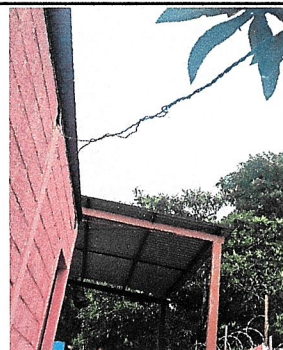
Foto 5: REPARACION DE SISTEMA ELECTRICO; SUSTITUCION DE CABLEADO DE ACOMETIDA PRINCIPAL.
