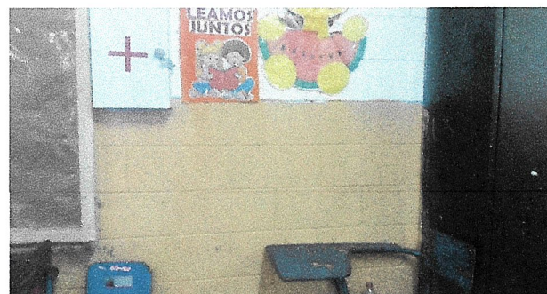
Foto 6: PINTURA EN MUROS INTERNOS Y EXTERNOS EN UN AREA DE 900M2
