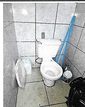
Foto 4: SUSTITUCION DE ARTEFACTOS SANITARIOS
