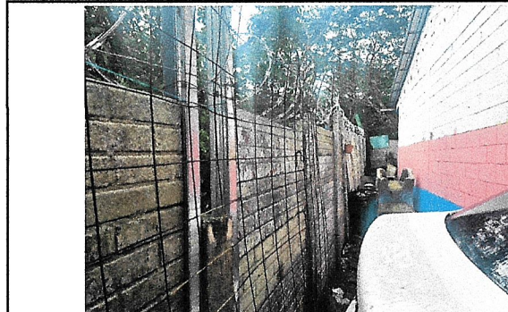
Foto 2: REPARACION DE MURO PERIMETRAL
