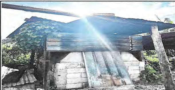
Foto 1 y 2 CUBIERTA DE LAMINA: (Cambio de cubierta de lamina area de cocina 48 metros cuadrados)
