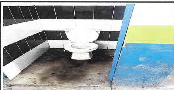
Foto 3: se hara cambio de servicios sanitarios :( Se cambiarian 4 sanitarios del area de hombre.
