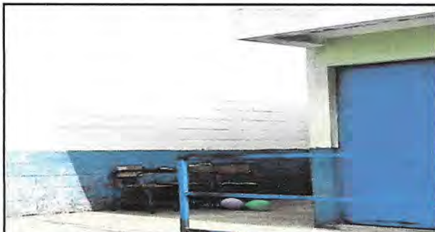
Foto 7: PINTURA DE MURO EXTERIOR (aplicación de pintura en cocina y otros ambientes)
