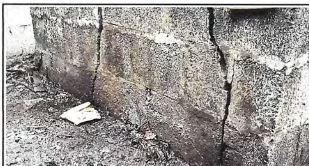
FOTO 11: REPARACION Y SUSTITUCION AREA DE COCINA: (cambio de muros dañados en area de cocina por muros nuevos de block)
