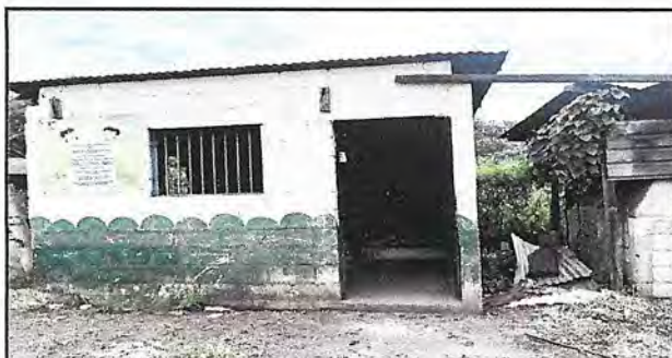
FOTO 9: VENTANAS: (sustitucion de ventanas de barrotes en area de cocina.)
