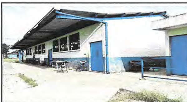
FOTO 10: CANALES Y BAJADAS DE AGUA PLUVIAL: (cambio de canal frontal de caída de agua 60 metros lineales)
