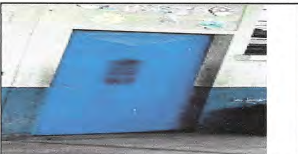
Foto 5 :PUERTAS (mantenimiento de puertas de baños)
