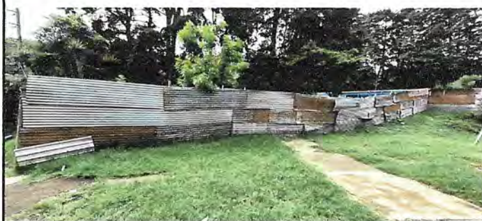
Foto4: Parte 2, Muro perimetral formal de 28 metros lineales por 3 metros de alto, para la seguridad de los estudiantes, vista de la parte de afuera.
