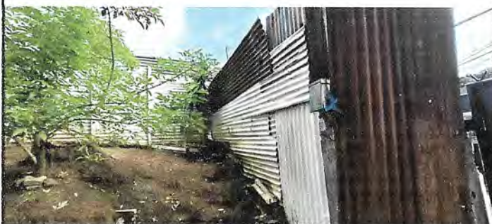
Foto5: Parte 3, Muro perimetral formal de 3.80 metros lineales por 3 metros de alto, para la seguridad de los estudiantes, vista de la parte de adentro.
