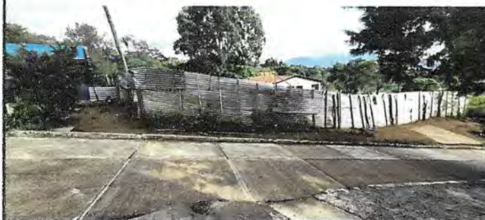
Foto3: Parte 2, Muro perimetral formal de 28 metros lineales por 3 metros de alto, para la seguridad de los estudiantes, vista de la parte de adentro.
