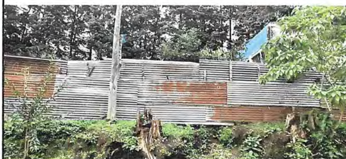
Foto2: Parte, Muro perimetral formal de 10.80 metros lineales por 3 metros de alto, para la seguridad de los estudiantes, vista de la parte de afuera.
