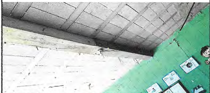
Foto3: Demolición de terraza de 50 metros cuadrados
