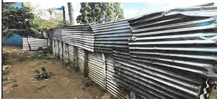
Foto1: Parte 1, Muro perimetral formal de 10.80 metros lineales por 3 metros de alto, para la seguridad de los estudiantes, vista de la parte de adentro.
