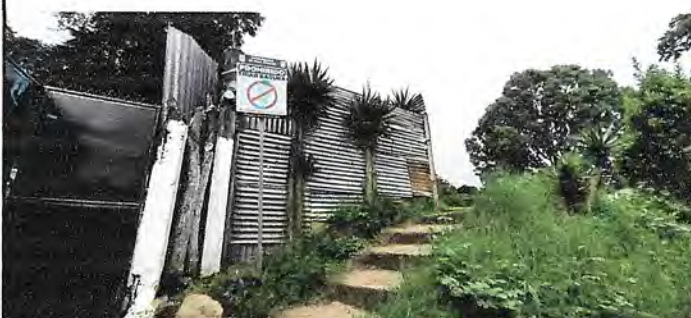
Foto6: Parte 3, Muro perimetral formal de 3.80 metros lineales por 3 metros de alto, para la seguridad de los estudiantes, vista de la parte de adentro.
