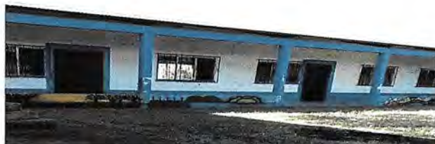
FOTO7: PINTURA EN MUROS EXTERIORES, aplicación de pintura latex.
