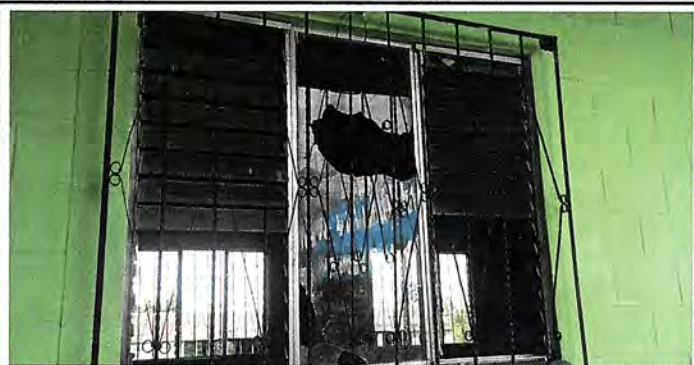
Foto 3: VENTANAS: Sustrucción de 12 ventanas de paleta en mal estado, por ventanas fabricadas a la medida de metal, abatibles y corredizas en dividida en dos tramos.
