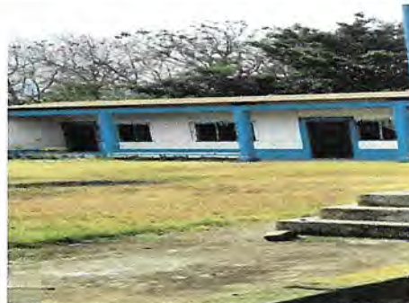
FOTO 8: PINTURA EN MUROS EXTERIORES a 80 m2 y 80.00m2 de aceite a dos manos en fachada principal.
