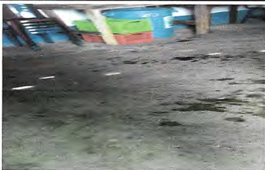
Foto 5: PISO: Sustrucción de piso rustico por piso entideslizante, por mal estado.
