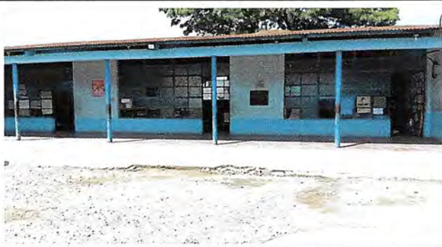
Foto 3: Sustitución de ventanas por ventanería pvc + adecuación de puerta.
