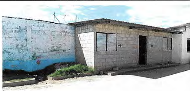
Foto 1: Sustitución de costaneras y lámina en área de cocina.
