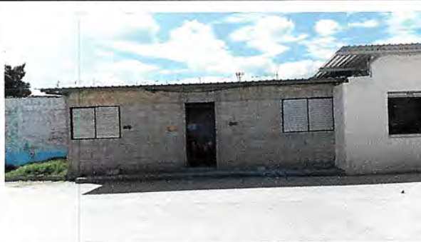
Foto 2: Reparación/Corrección del nivel de muro de 2.70m a 3.30m que integra un área de 19.5m2
