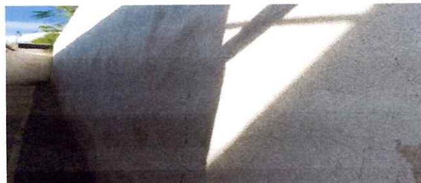
Foto: 16 REPELO DE MURO PERIMETRA INTERNO
