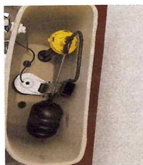
Foto: 4 ACTUALEMTE LOS DEPOSITOS YA NO LLENAN Y LAS TAZAS DE LOS SANITARIOS ESTAN
