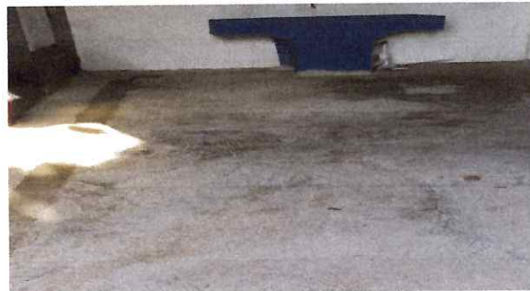
Foto: 8 COLOCACION DE PISO ANTIDESLIZANTE EN EL AREA DE PILA Y SANITARIOS.
