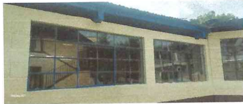
Foto: 4 Cambio de ventana
