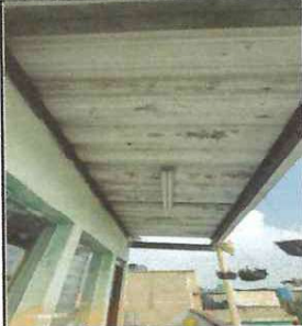
Foto: 1 Cambio de lamina
