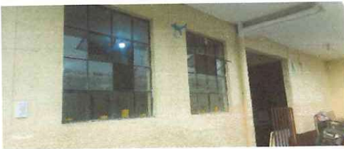
Foto: 3 Cambio de ventanas
