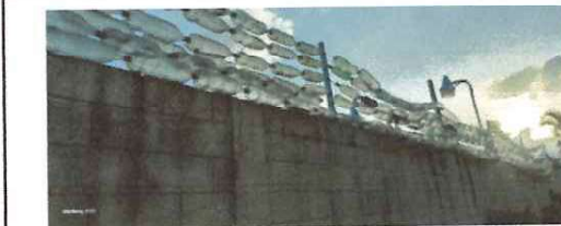
Foto: 2 Mejora en muro perimetral
