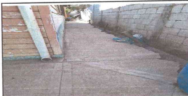
Foto: 3 Construcción de cuneta (continúa)
