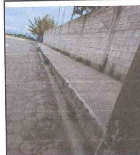
Foto: 6 Instalación de 24 metros lineales de drenaje hacia candela principal.
