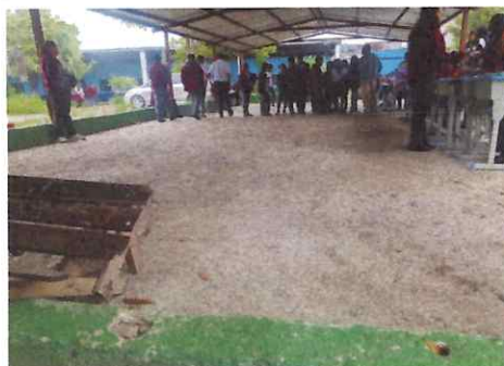
Foto: 2, Mejoramiento de torta de concreto en galera.
