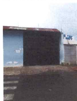
Foto: 4, Mejoramiento de porton Principal.
