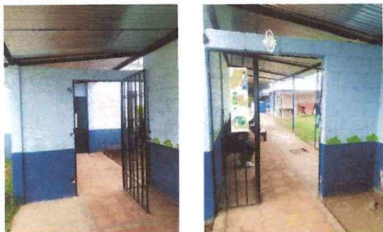
Foto: 1, Mejoramiento de puerta de reja.
