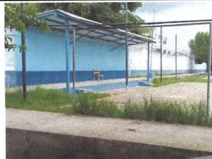
Foto: 6, Pintura para mantenimiento de pared exterior.
