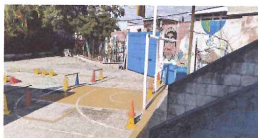
PINTURA DE LAS AREAS EXTERIORES.
