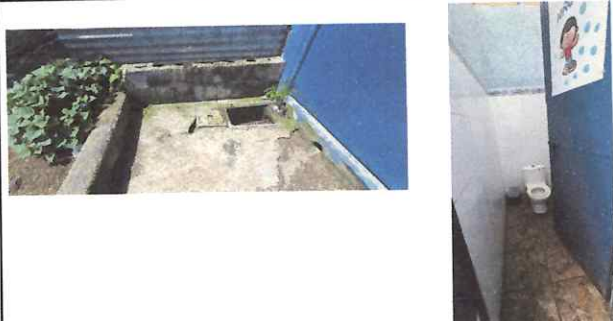
FOTO 1: Mantenimiento de drenaje de agua pluvial y sustitución de sanitario.
