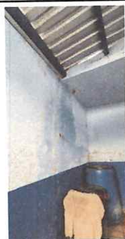
Foto: 5, Impermeabilización de pared parte posterior.
