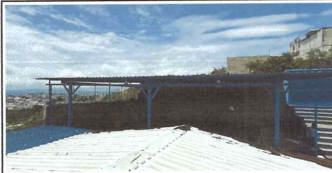
Foto: 6 Instalación de canal
