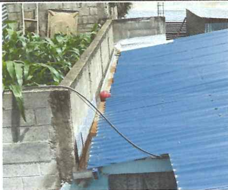
Foto: 7 Cambio de canal en mal estado
