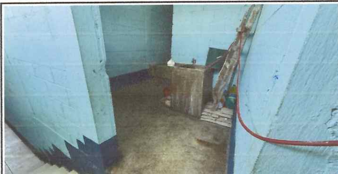
Foto: 3 Colocación de piso cerámico antideslizante en baños de mujeres y hombres, también colocación de azulejo
