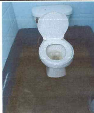
Foto: 4 Cambio de tubería de sanitarios de mujeres y hombres también de pilas
