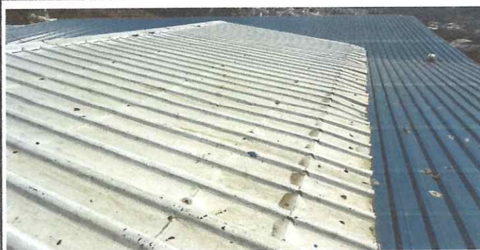
Foto: 1 Cambio de lámina y mantenimiento de estructura metálica por lámina quebrada y con gotera.
