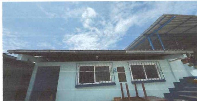
Foto:8 Cambio de canal en mal estado
