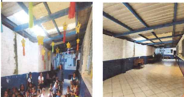
Foto: 5 cambio de laminas transparentes en todo el corredor.
