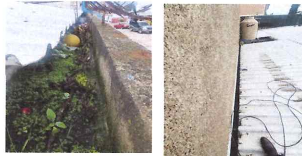
Foto: 4 limpieza, y verificacion del ingreso de agua por el lado de la direccion
