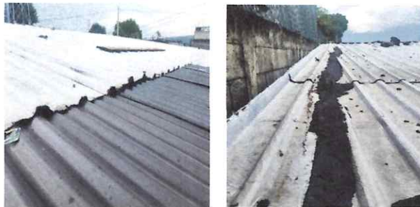
Foto: 3 mantenimiento y cambio de tornillos en las otras tres aulas
