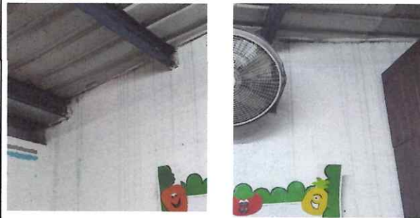
cambio de laminas en dos aulas y la colocación de cielo falso en todas las aulas
