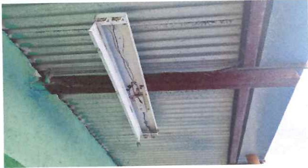
Foto 1: Mejoramiento de iluminación en aulas y corredores de los establecimientos.
