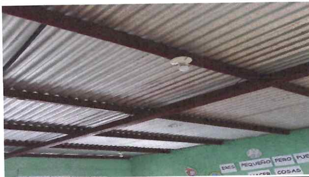
Foto 3 : Aplicación de pintura anticorrosiva en la estructura
