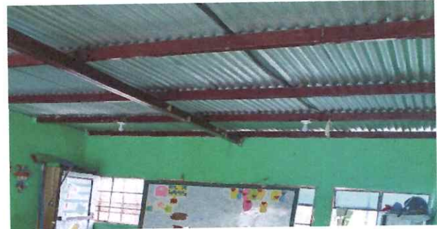
Foto 4: Cambio de techo en segundo nivel con la colocación de laminas termoacusticas
