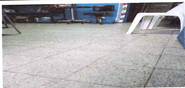
FOTO: 1 CAMBIO DE PISO DE COCINA DE LA JORNADA VESPERTINA
