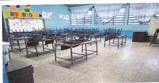
Foto: 5 CAMBIO DE PISO DEL AULA DE EN MEDIO DEL PRIMER MÓDULO
