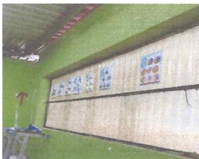
Foto: 1. VENTANA Sustitución de Ventana de metal por pvc
