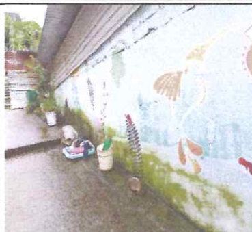
Foto: 2. Pintura en muros exteriores e interiores (Impermeabilizante en muro, marquesina)
