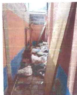
Foto: 4, Puertas de metal para area de basurero.
