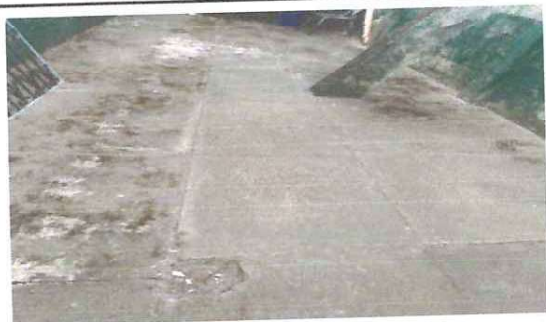
Foto 5: pasillo para ingreso de baños de jóvenes
