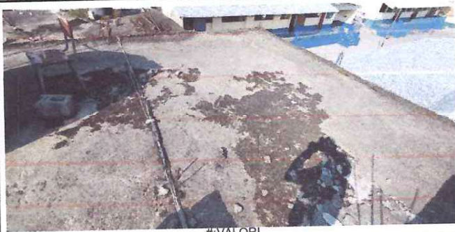
Foto5: IMPERMIABILIZAR TECHO DE DIRECCIÓN
