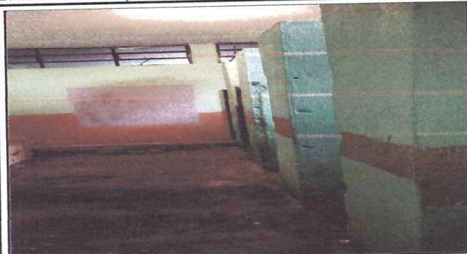
FOTO1: REMOZAMIENTO DE BAÑO DE VARONES
