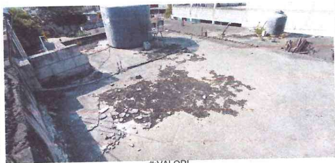
Foto 6: IMPERMIABILIZAR TECHO DE DIRECCIÓN
