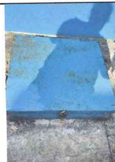
Foto: 6 Mantenimiento a cisterna
