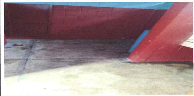
Foto 6: colocacion de psio sanitario para niñas
