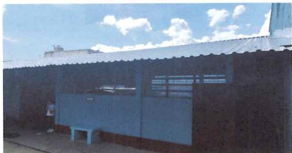
Foto 7: colocacion de canales
