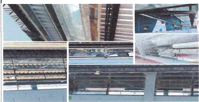
Foto 2: Mejoramiento de ventanas
