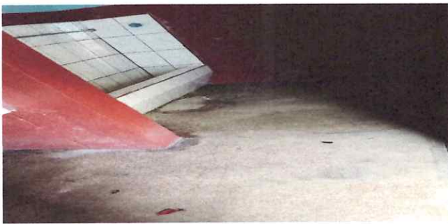
Foto 5: colocación de piso en sanitarios niños
