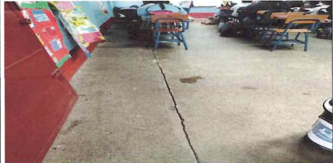
Foto 4: colocacion de psio salon 3
