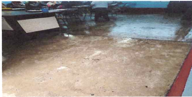
Foto 1: Colocación de piso salon 1
