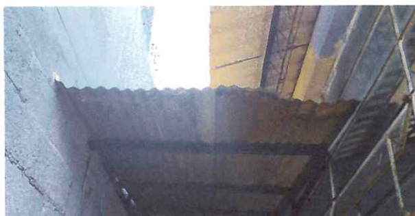
Foto 8: Cambio de lámina
