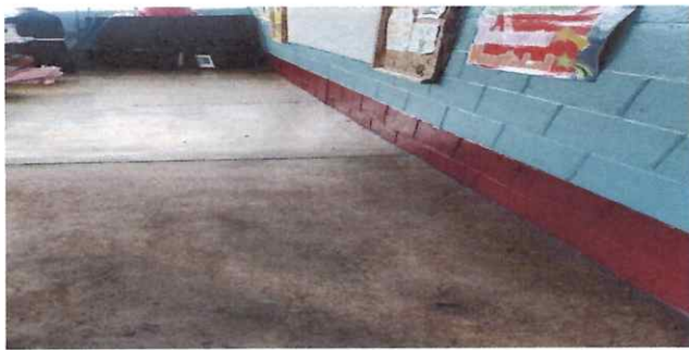
Foto 3: colocacion de psio salon 2
