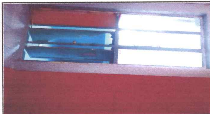
Foto 9: Remodelación ventana frotal de 3ro
