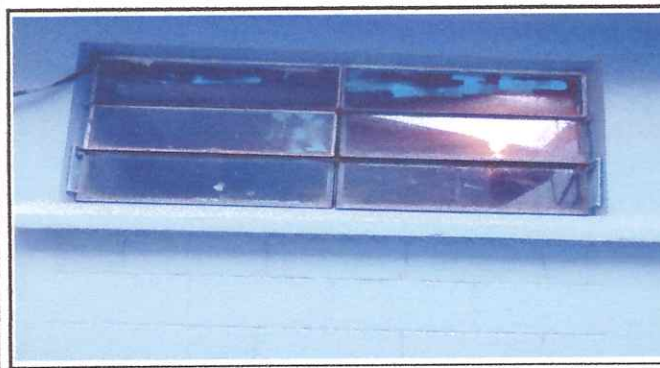
Foto 5: Remodelación de ventana 3ro
