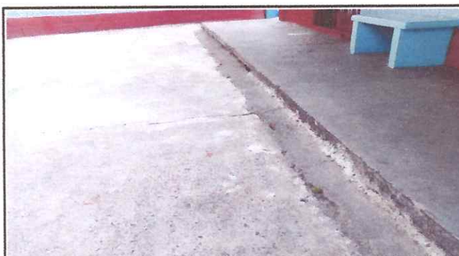
Foto 3: Remodelación de patio
