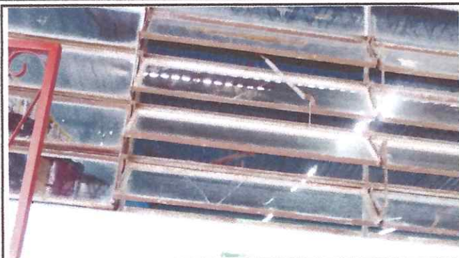
Foto 1: Remodelación de ventana 1ro
