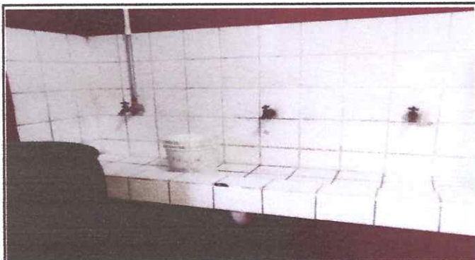
Foto 7: remozamiento mingitorio lado frontal
