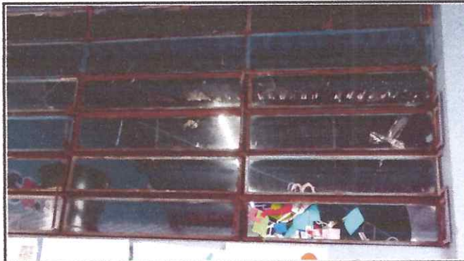
Foto 2: Remodelación ventana 4to
