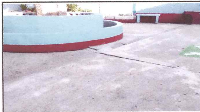
Foto 4: Remodelación de patio lado frontal
