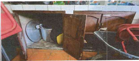
Foto: 1 Mejoramiento de cocina: instalación de azulejo
