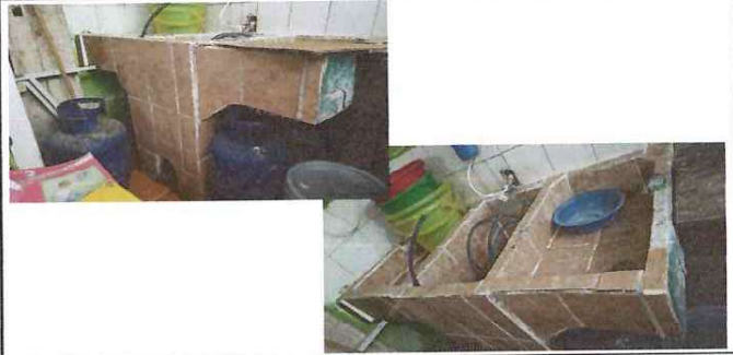
Foto: 2 Suministro e instalación de pila
