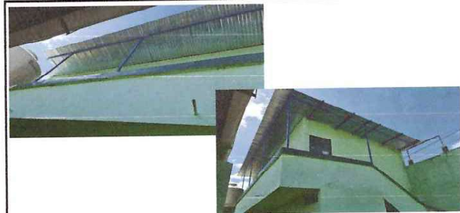
Foto: 6 Suministro e instalación de baranda de 11m2
