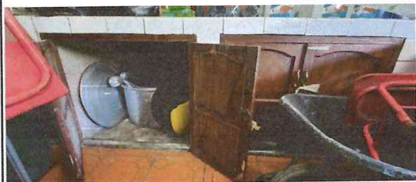
Foto: 1 Mejoramiento de cocina: instalación de azulejo
