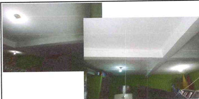
Foto: 4 Cambio de 4 focos de 75 wats Led en cocina
