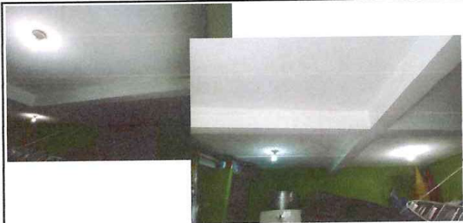
Foto: 4 Cambio de 4 focos de 75 wats Led en cocina
