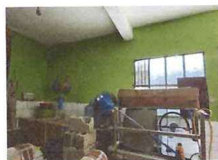
Foto: 5 Suministro e instalación de ventana de 1 x 1 m2
