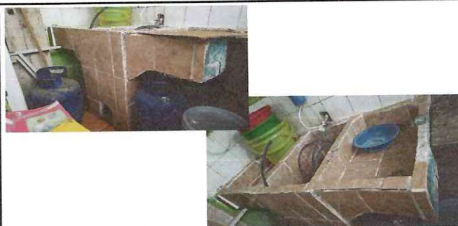
Foto: 2 Suministro e instalación de pila
