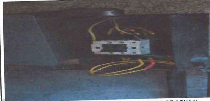
Foto: 2 CAMBIAR EL TABLERO ELECTRICO DE LA BOMBA DE AGUA Y CAMBIAR LA TUBERIA DE PVC EN DONDE ESTA LA BOMBA
