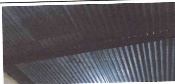
Foto: 4 CAMBIO DE LAMINA DEL TECHO DEL SALÓN DE SEXTO SECCIÓN C
