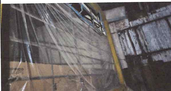
Foto: 6 Cambio de ventanas metálicas por ventanas de pvc aula 2 (18.23 mts)
