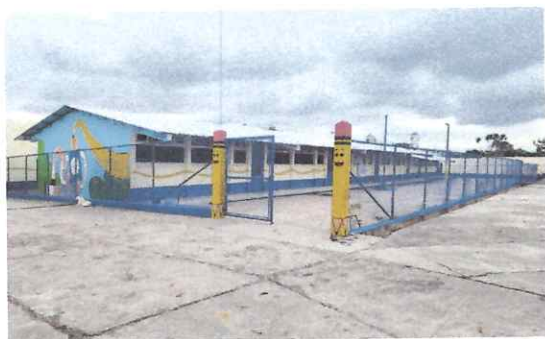
Foto: 1 Realización de cambio de malla área de preprimaria (73 mts largo x 2 mts de alto) total 146 mts
