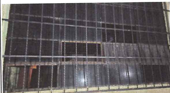
Foto: 5 Cambio de ventanas metálicas por ventanas de pvc aula 1 ( 16.14 mts)
