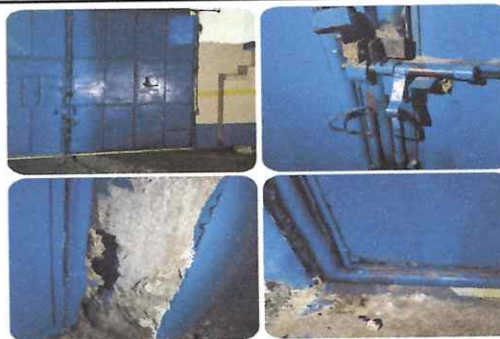
Foto: 4 Realización de cambio de portón para entrada principal parte trasera (3.96 mts x 3.20 mts ) total 12.97 metros
