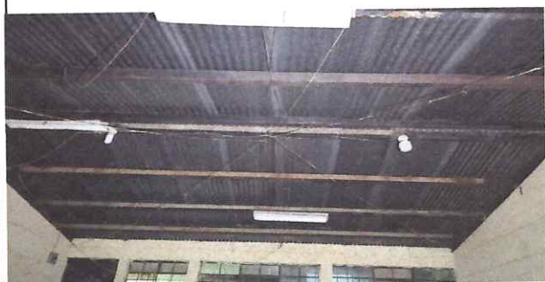
Foto: 3 Realización de cambio de lámina en AULA 2 (7.67 mts x 8.00 mts (total 61.36)
