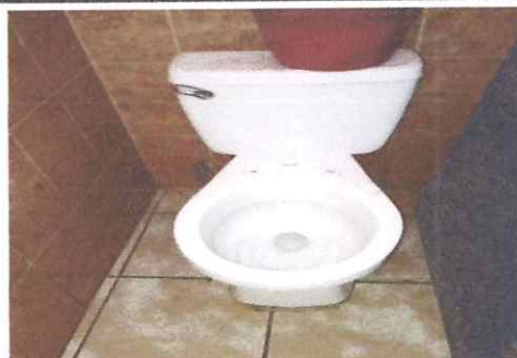
Foto: 2 MEJORAMIENTO DE SANITARIOS
