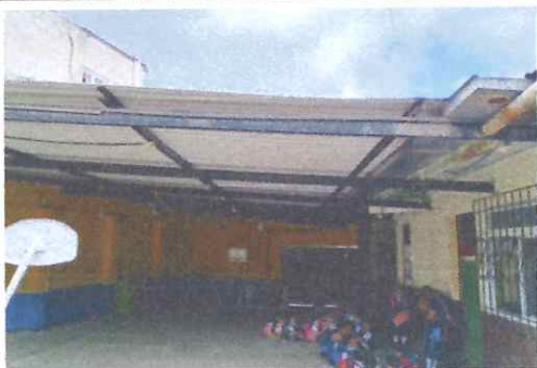
Foto: 1 MEJORAMEINTO DE TECHO
