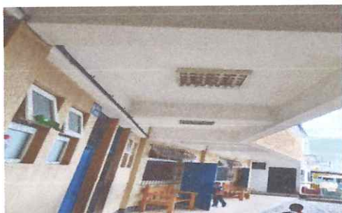
Foto: 3 MEJORAMIENTO DE SISTEMA ELÉCTRICO
