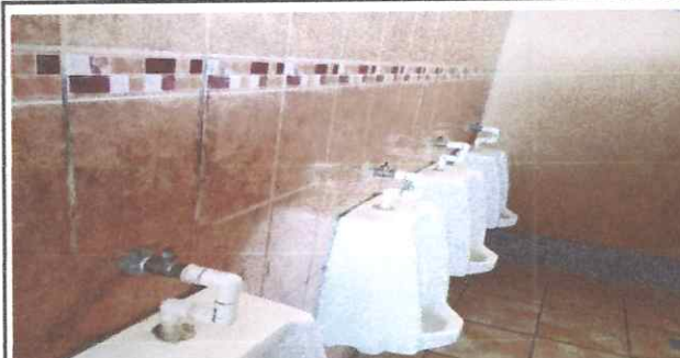
Foto: 6 MEJORAMIENTO DE SANITARIOS
