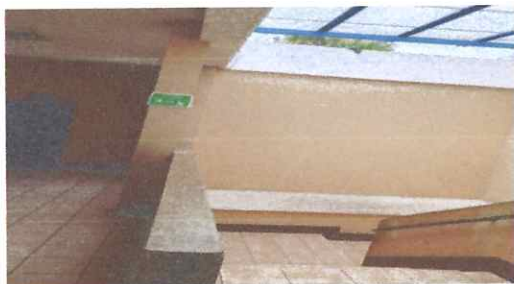
Foto: 5 COLOCACIÓN DE BALCÓN
