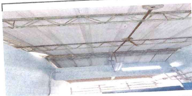
Foto: 6 Cambio de lamina y pintura de joist del area de baños, modulo 2
