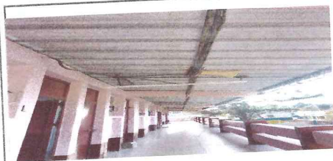
Foto: 5 Frente del modulo 2, cambio de lamina y pintura de Joist.
