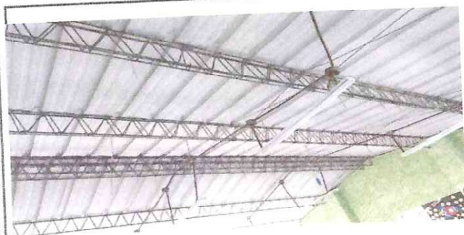
Foto: 3 Se pintaran los JOIST de los salones del modulo 2
