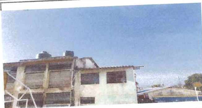
Foto: 2 Parte trasera de la bodega del modulo 2 donde se cambiara el techo.
