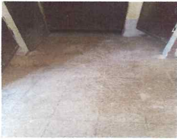
Foto 1: Piso en baño niños, piso en baños de niñas y reparacion de tuberia ya que esta tapada la reposadera
