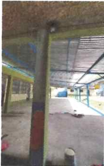
Foto 5: Colocacion de tubo detrás de columna para agua
