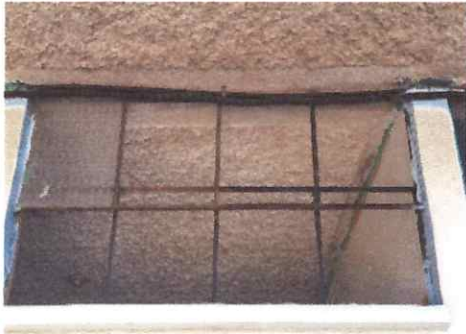
Foto 2: Sustitucion de balcones.
