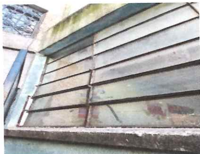
Foto 1: Suministro y cambio de ventanas de metal por pvc corredizas
