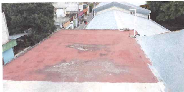
Foto 4: Aplicación de impermeabilizante con malla de refuerzo (elastomeric)
