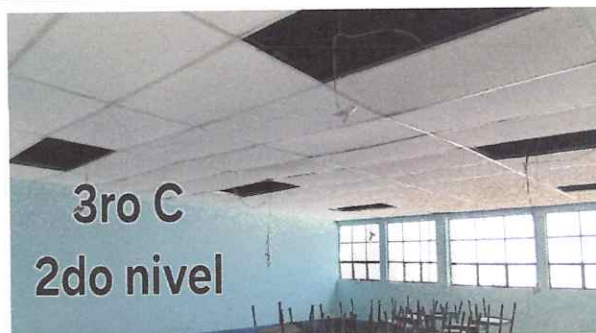
Foto 2: Mejoramiento del sistema eléctrico en ocho salones
