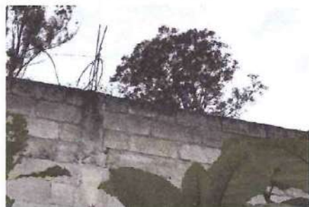
Foto: 3 Cercos cortados lado trasero
