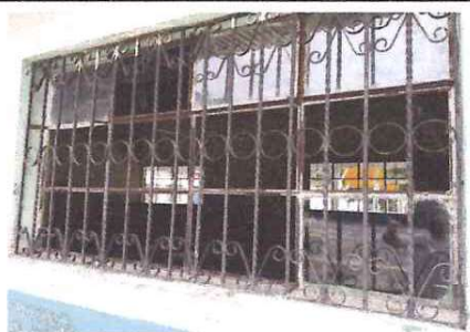
Foto: 1 Ventana del módulo 3 frente
