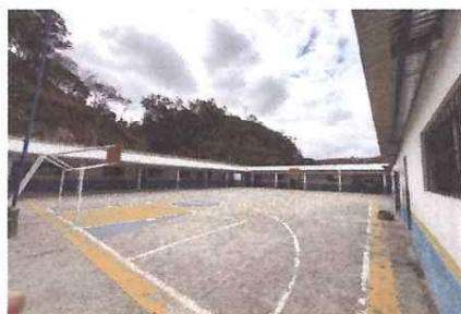
Foto: 3 Panorama general de las ventanas
