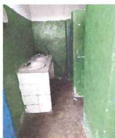
Foto: 5 piso de baños de niñas
