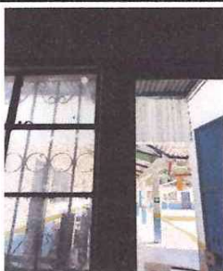
Foto: 5 No hay energía eléctrica
