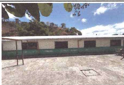
Foto: 5 Ventanas módulo 1 atrás
