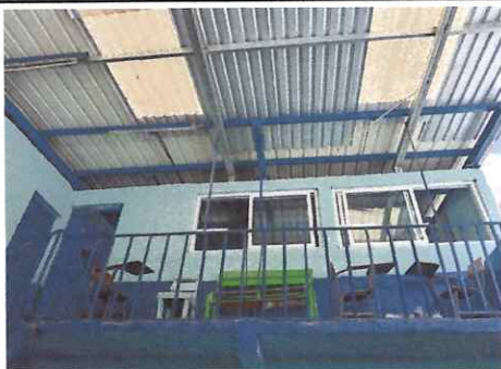
Foto: 5 Instalación de baranda en el segundo nivel.
