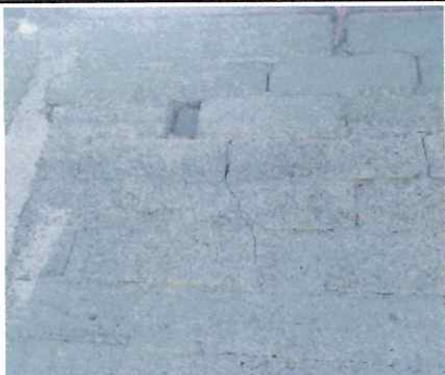
Foto: 1, Reparación de 8 columnas en la dirección.
