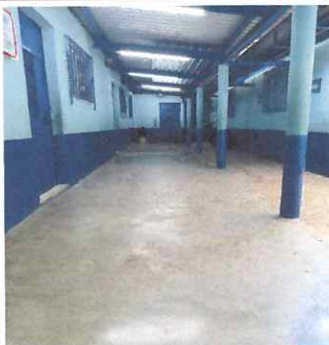
Foto: 3, Colocación de piso antideslizante en el corredor.
