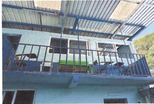
Foto: 2, Instalación de barros en aula de segundo nivel.
