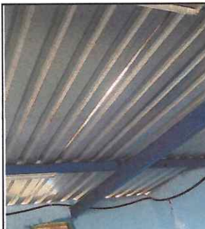
Foto: 4, Reparación de techo en escuela, reparación de puerta en aula 2.
