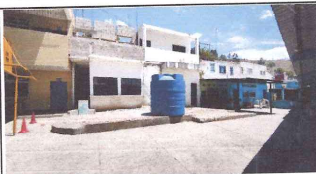
Foto: 4 Nivelar patio
