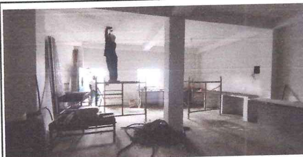
Foto: 6 Colocación de piso sobre torta en la cocina.
