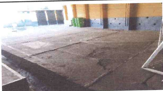
Foto: 5 Mejoramiento de patio
