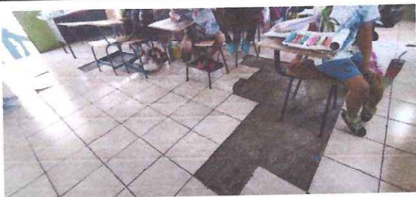
Foto: 1 Cambio de Piso en 3 aulas en mal estado.
