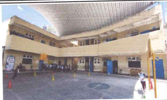
Foto: 2 Pintura para la parte externa del edificio.
