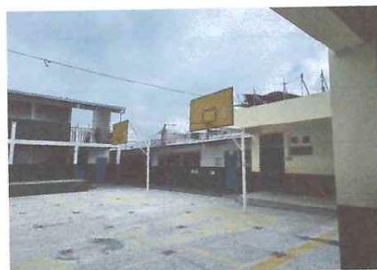
Foto: 6 Alumbrado en patio
