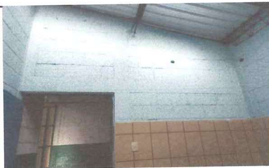
Foto: Pintura en paredes
