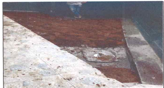
Foto: 4, Relleno y torta para desnivel de area del patio.
