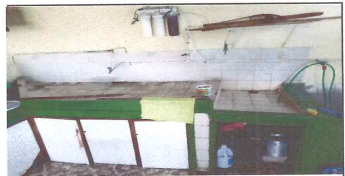
Foto: 6, instalación de azulejo en cocina.
