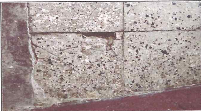
Foto: 1, Instalacion de piso ceramico
