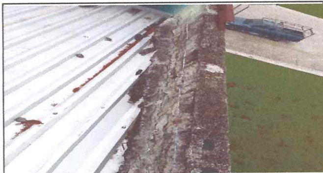
Foto: 3, impermeabilización de pared y cambio de lámina
