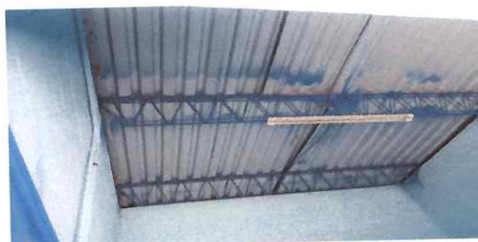
Foto: 4 Colocación de cielo falso en dirección
