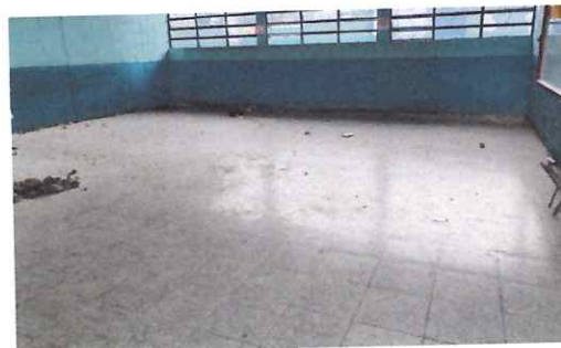
Foto: 2 Cambio de piso
