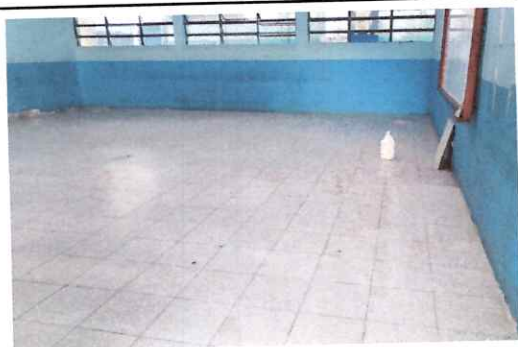
Foto: 3 Cambio de piso
